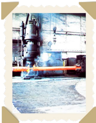
Freiformschmiedepresse mit 5.000 kN Pressdruck und Schmiedemanipulator für 2.500 kg Blockgewicht.
