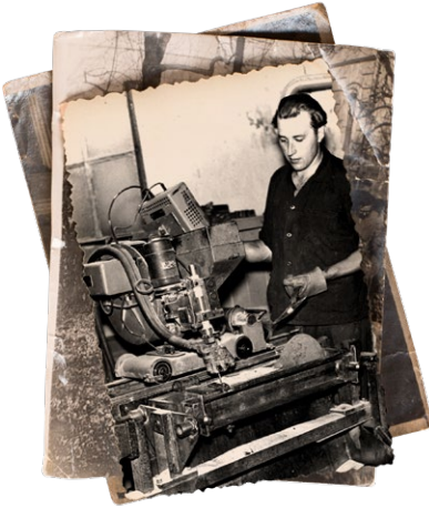
Bohren und Fräsen von geschmiedeten Zughaken.
