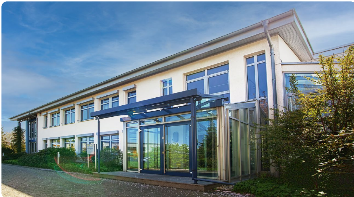
Das Verwaltungsgebäude, seit 1998 der Hauptsitz des Unternehmens
